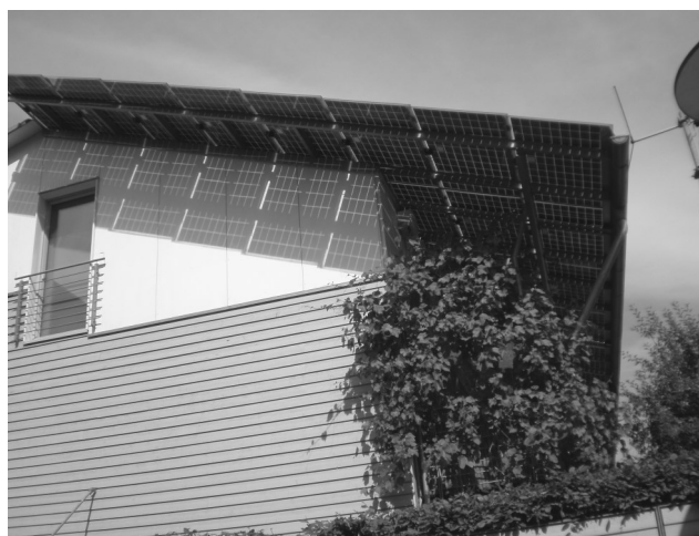
外の熱を室内に入れないために大きく伸びた庇。屋根そのものが太陽光発電機です。
